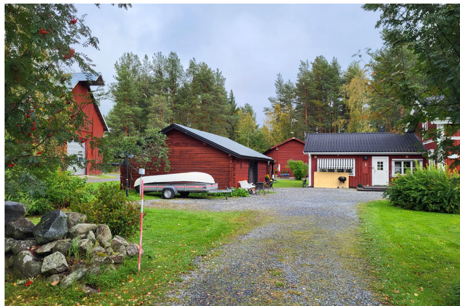
Vy mot infart till en av de stora gårdarna, som omfattar ett stort antal byggnader. Del av tomten omgärdas av stenmurar.
