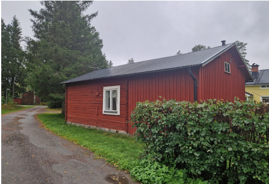
Ålderdomlig ekonomibyggnad placerad nära den smala grusvägen.
