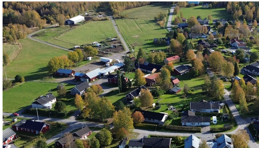
Vy mot sydöstra delen av Benzeliussvägen, där den övergår till en smalare grusväg. Här ligger gårdsläget Verners med bl.a. en mycket långsträckt ladugårdsbyggnad och en äldre gul man-gårdsbyggnad.
