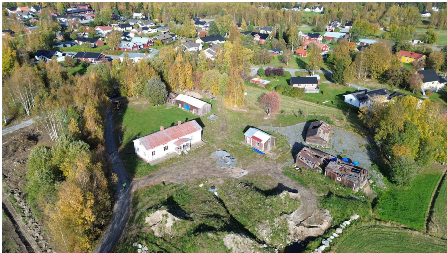
Gårdsläge strax söder om Skärgårdsvägen längs Stenåsvägen. Några av ekonomibyggnaderna är i mycket dåligt skick.
