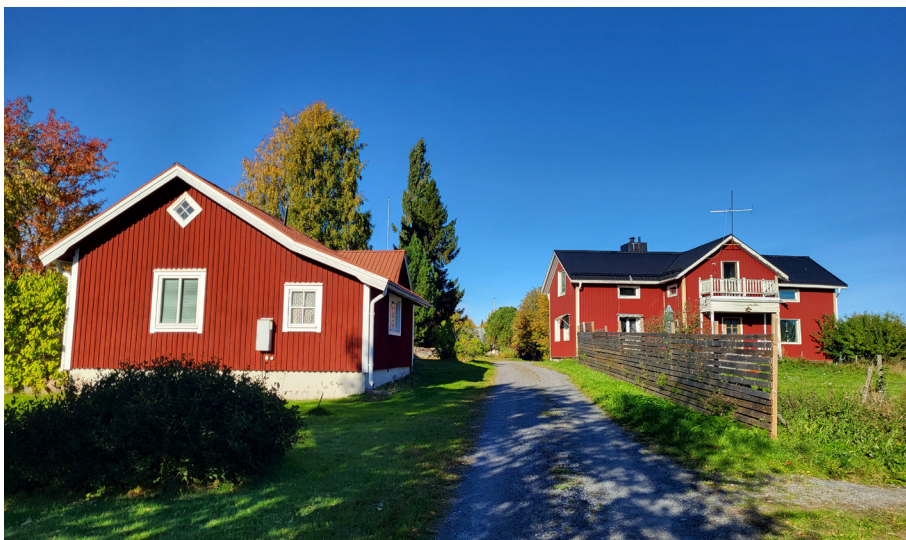
Mangårdsbyggnad till gårdsläget Verners till höger, östra delen av Benzeliusvägen.
