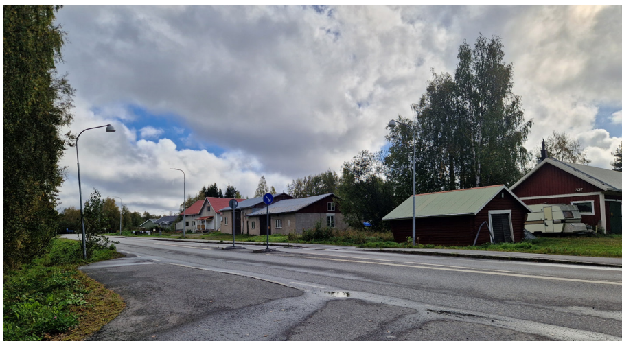
Verkstad, ekonomibyggnader och villa närmast Björsvägen, i närheten av Holmen.
