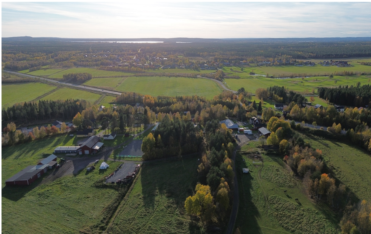
Flygvy mot Brännans från nordöst, med gården Olssons nere till vänster och fortsättningen på E10 som korsar igenom bystrukturen uppe till vänster.
