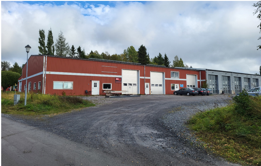
Garage- eller hallbyggnad på östra sidan av Valles backe.
