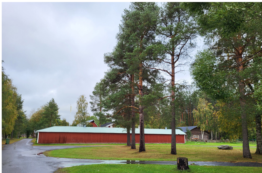
Långsträckt låg ekonomibyggnad placerad nära vägen.
