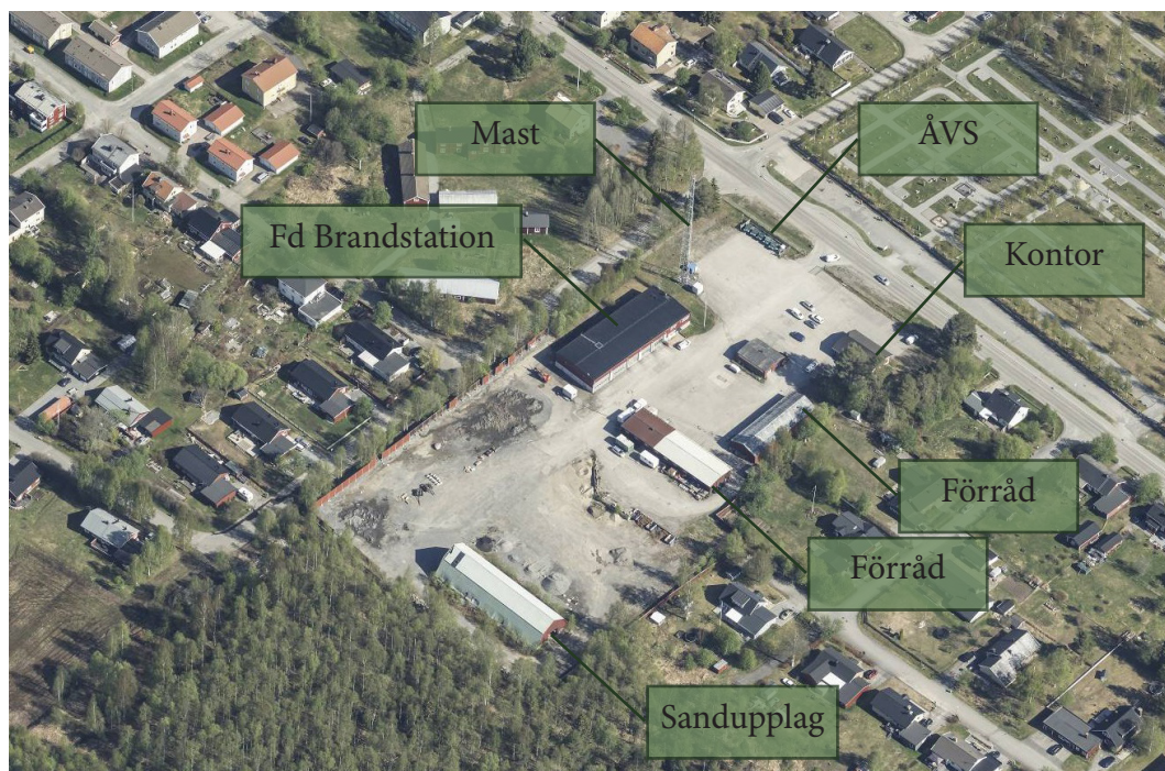
Flygfoto 2022, befintliga byggnaders funktioner. (Luleå Kommun)
