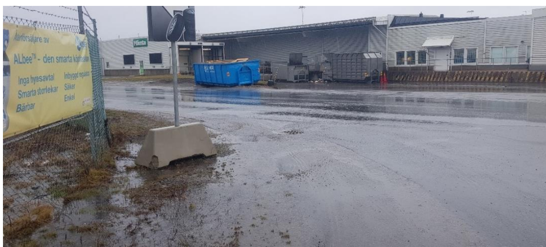
Figur 15. Foto som visa lastkajen där dagvatten kan rinna ner och ställa sig till ett djup om maximalt ca 0,9 m.
