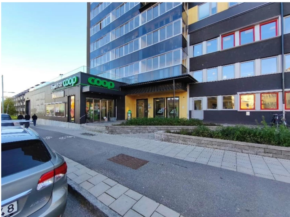
Figur 7 Västra Varvsgatan 18, Coop och Entré till bostadshuset. Infart till Coops lastkaj ligger i bortre änden av byggnaden, man kan se öppningen bakom de tre personerna i fotot. Angöring till entrén är knepig för flyttbilar och ambulanstransporter.
