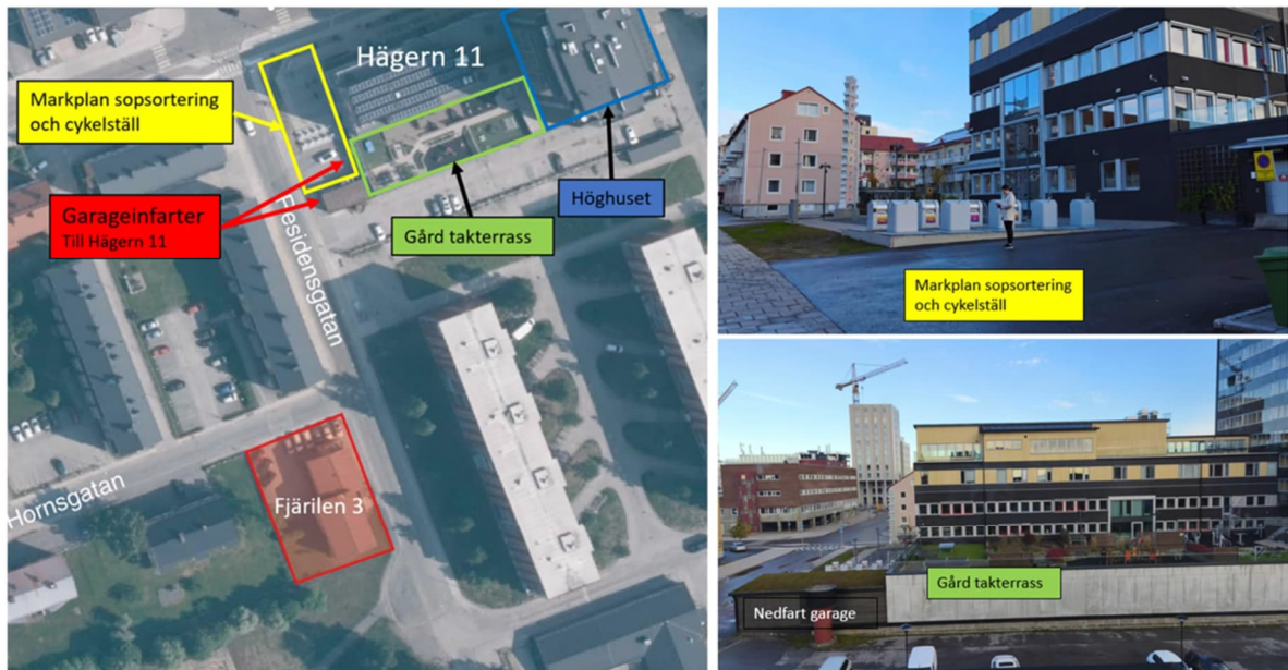
Figur 8 Hägern 11 med gårdsytor, infarter till garage samt planområdet Fjärilen 3. Man kan tydligt se befintlig byggnad med parkerade bilar på fastigheten Fjärilen 3. Parkeringar som försvinner om den tilltänkta byggnaden ska ligga dikt an fastighetsgränsen.
