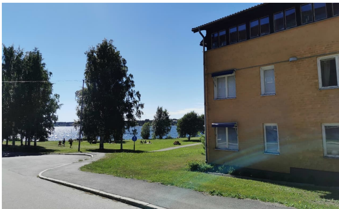
Figur 16: Lågpunkt vid befintlig byggnads sydöstra hörn där översvämningrisk föreligger.
