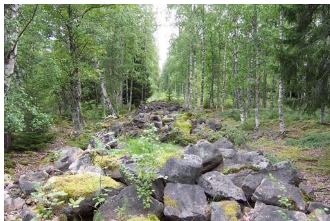
Grunden efter Decauvilspåret, i anslutning till spång G. Spåret ska vara fritt från sly och träd och området mellan spåret och stigen siktröjt.
