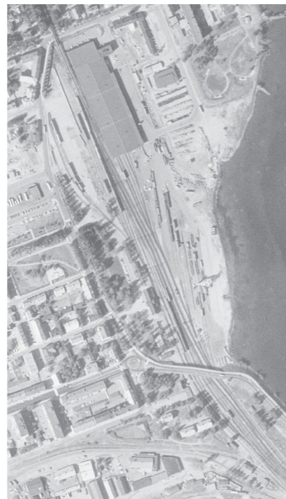
Bild 92. Flygfoto från ca 1975 med den sista stora markutfyllnaden för en rangerbangård och utökad godshantering.
