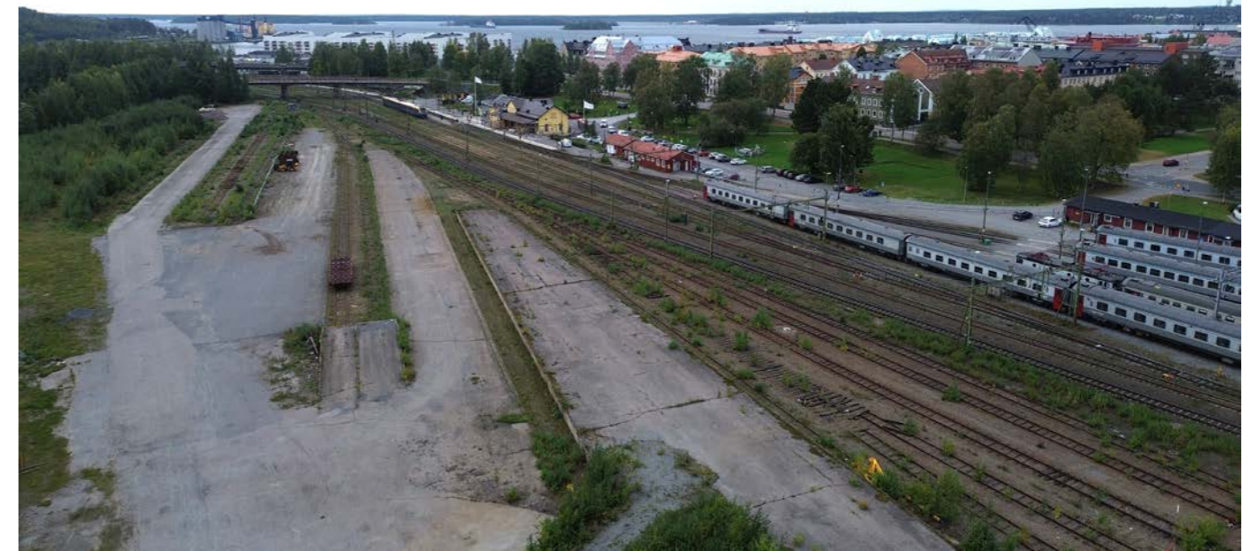
Vy mot söder längs spårområdet. Närmast i bild till vänster syns stickspåren som ett tydligt spår av den tidigare verksamheten inom bangårdsområdet. Till spåren hör även en hårdjord plattform och en liten ramp.
