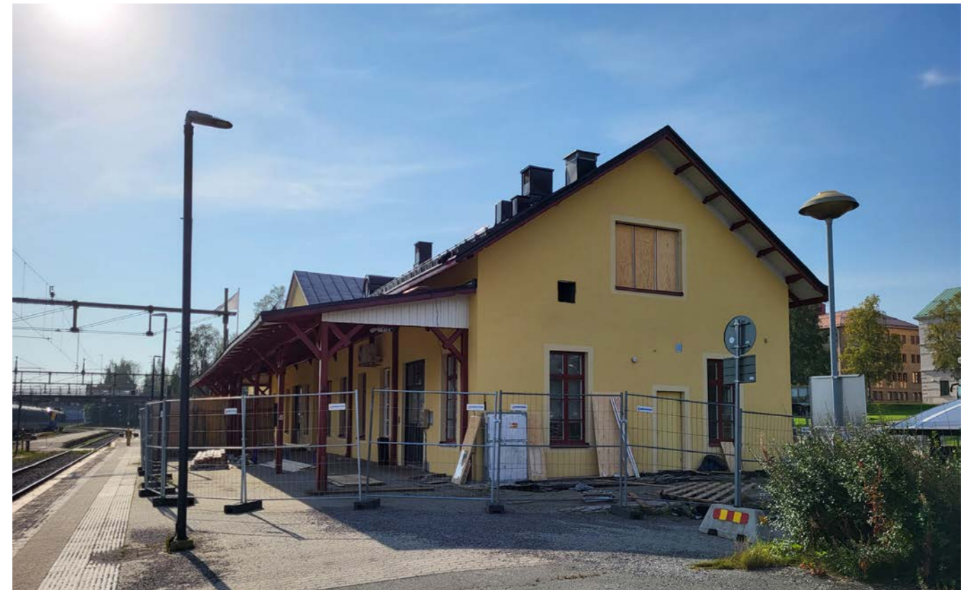
Stationsbyggnaden sedd från norr.
