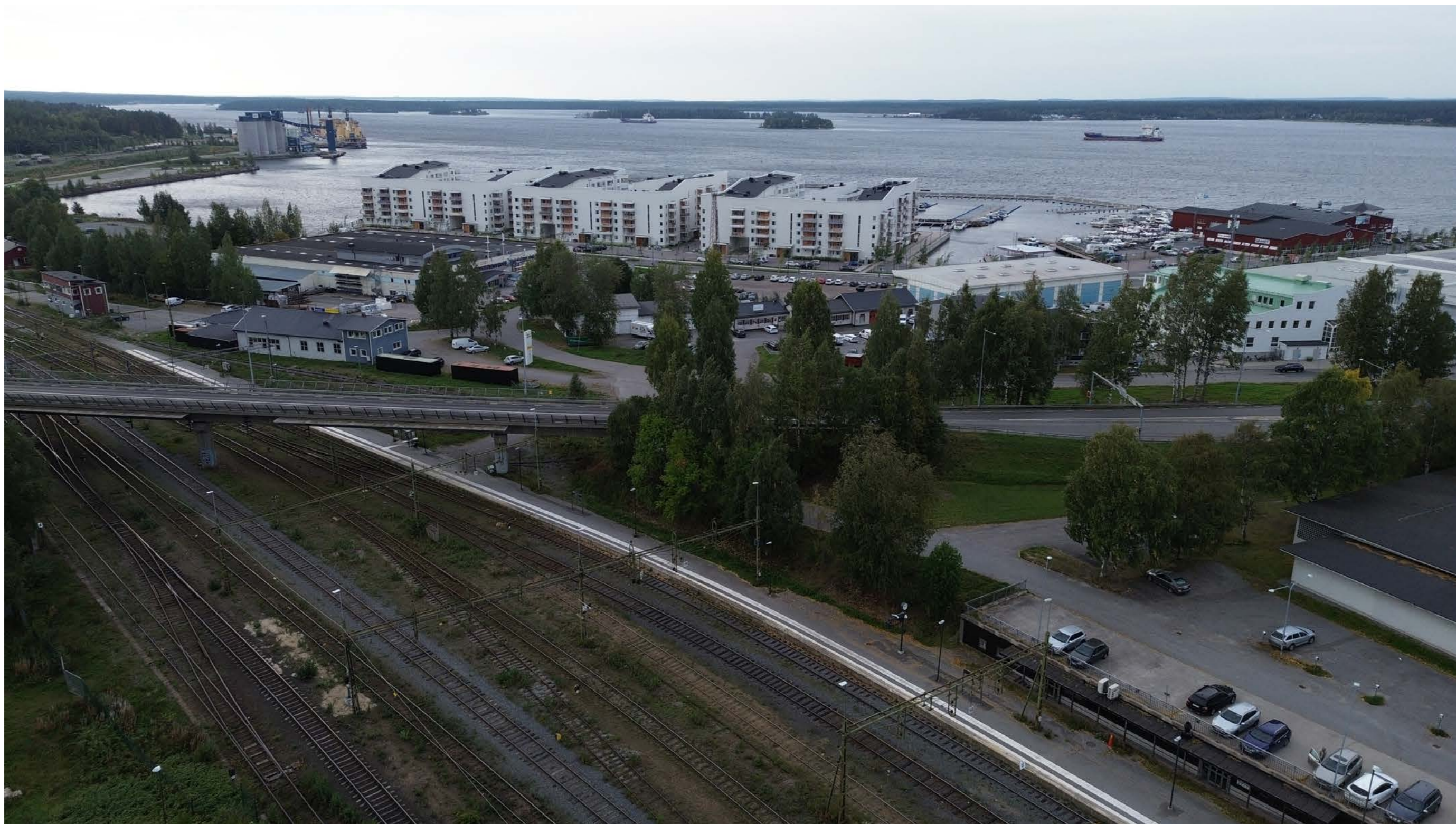
Flygvy över del av spårområdet mot Södra hamn och Malmhamnen på Svartön längst till vänster. Hertsövägen korsar det stora spårområdet
