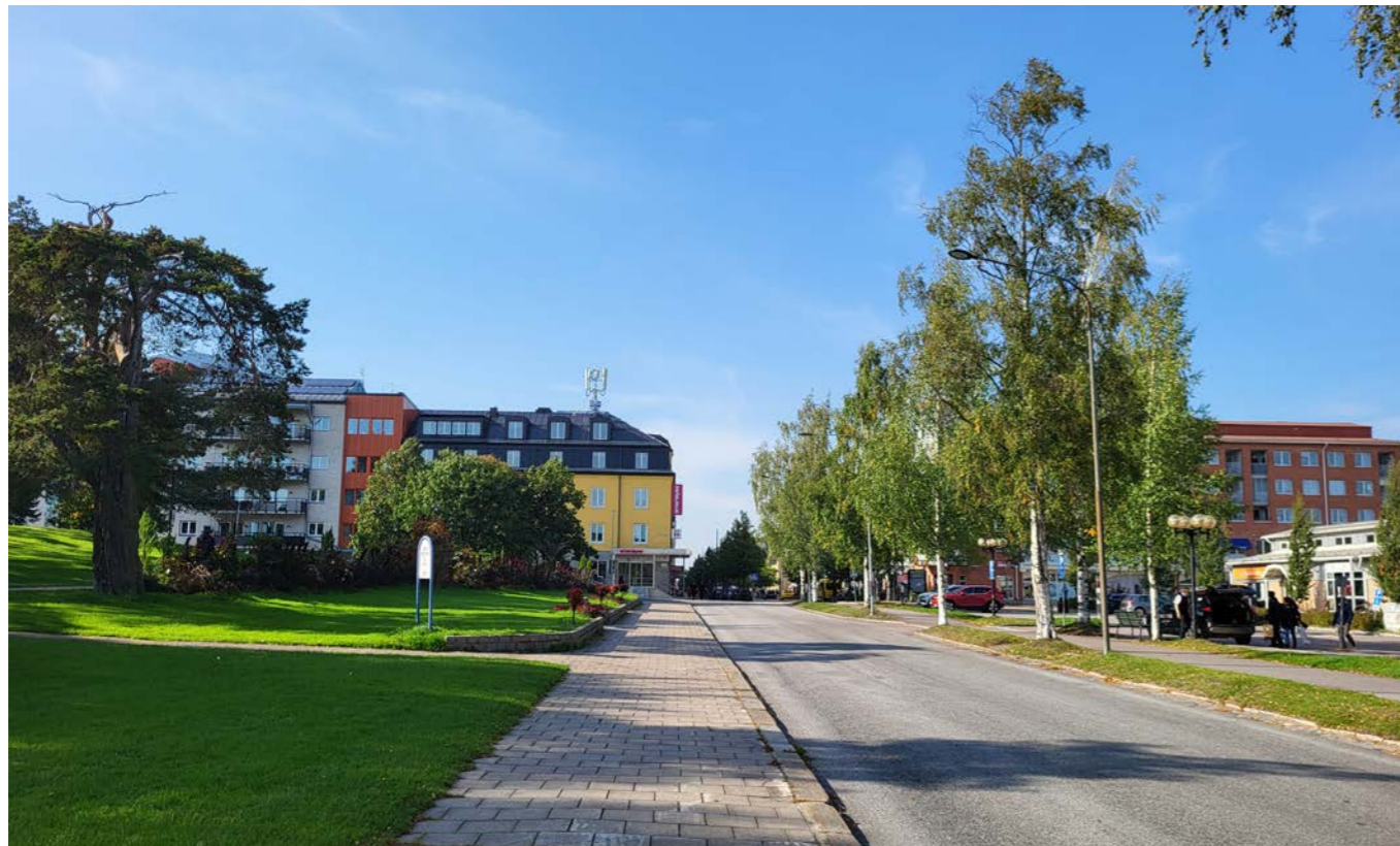
Vy mot sydväst längs Storgatan med Floras kulle till vänster och busstationen till höger. Högra sidan av gatan kantas av björkar. F.d. Producentföringens gula hus rakt fram markerar början på de tätbebyggda kvarteren och har en viss monumentalitet som ger dignitet till platsen.
