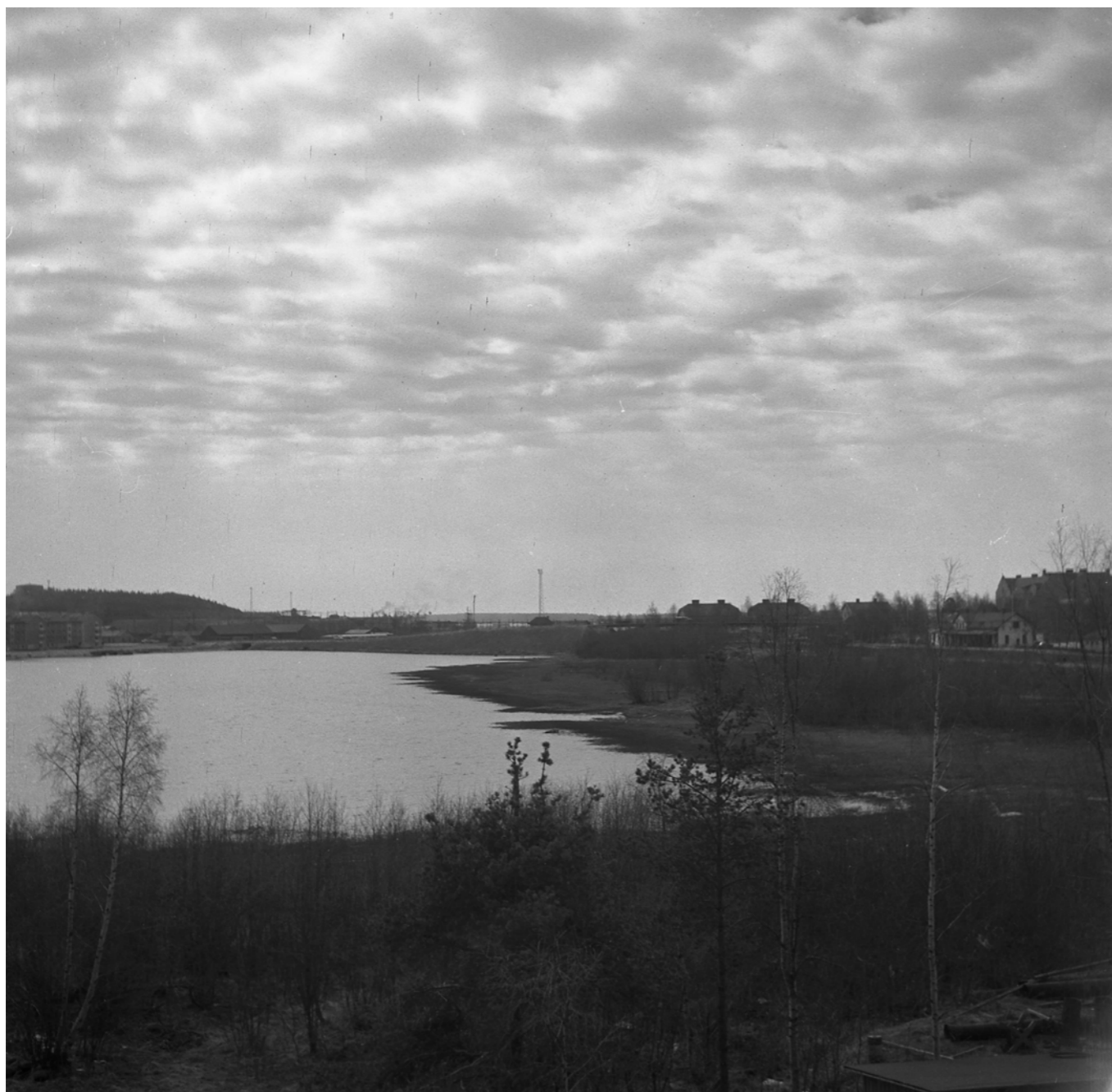
Foto över Skurholmsfjärdens strandlinje under arbete med att bredda spårområdet genom utfyllnader år 1953. Järnvägsstationen och godsmagasinet till höger. Bilden fotograferad från Kommunalhemskvarteret. Foto: Helmer Widlund, Luleå kommuns stadsarkiv.
