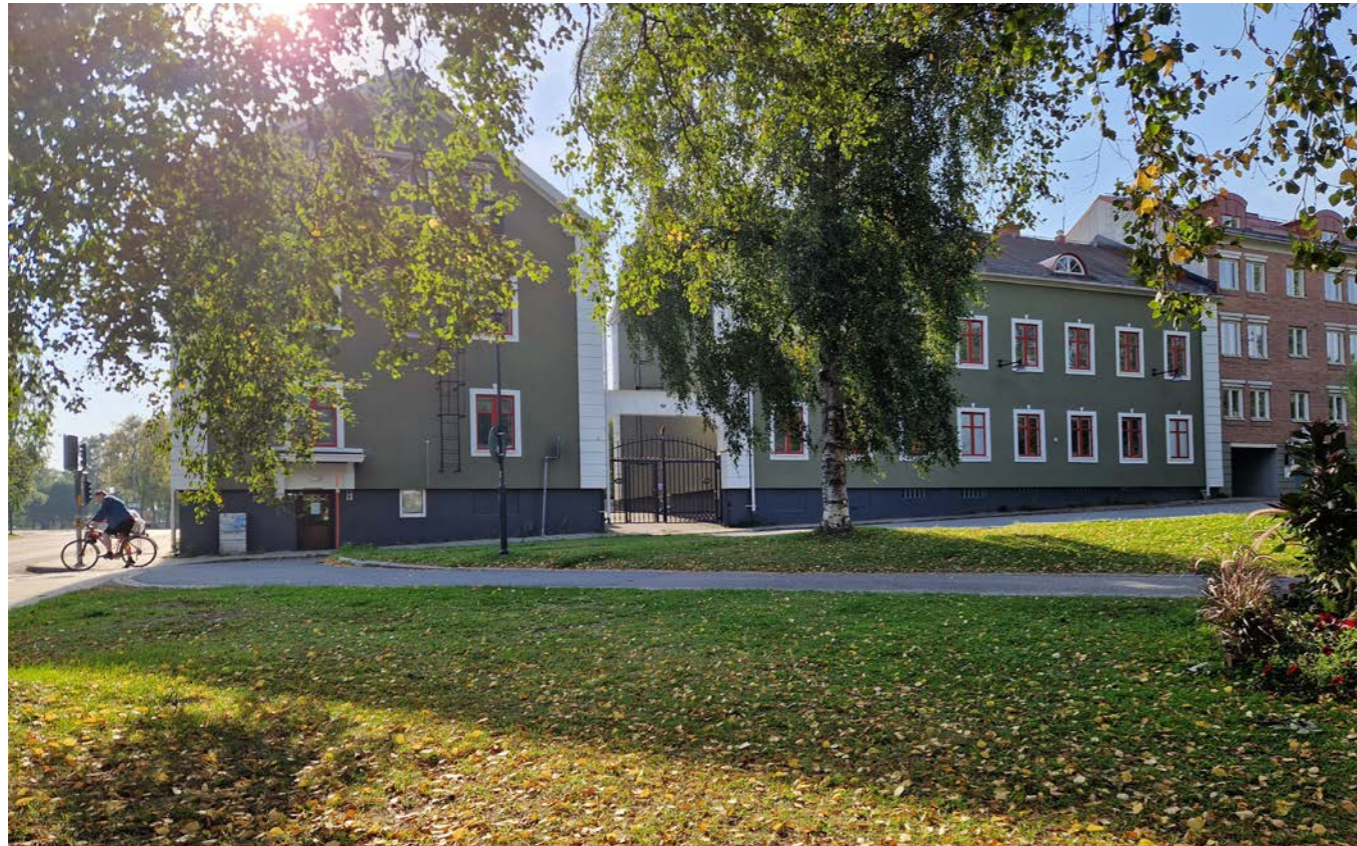
Vy mot Kv Flundran längs Köpmangatan, sett från norra delen av Floras kulle. Prästgatan längst till vänster.
