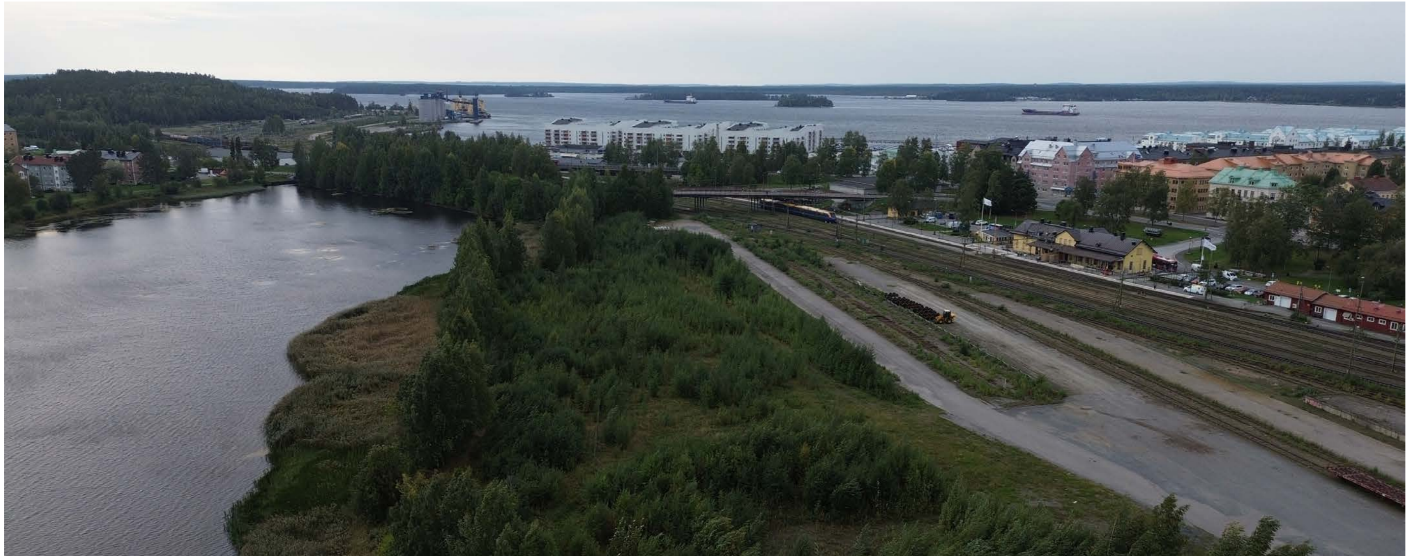
Flygvy mot söder över spårområdet, bangården och östra stranden vid Skurholmsfjärden. Rakt fram i bild syns delar av Södra hamn. Till vänster syns Svartön med Svartberget, den gamla malmhamnen och i förgrunden Malmudden. I strandområdet finns vildvuxen och slyig vegetation. Malmuddsviadukten bildar en länk över spårområdet från innerstaden till Malmudden.
