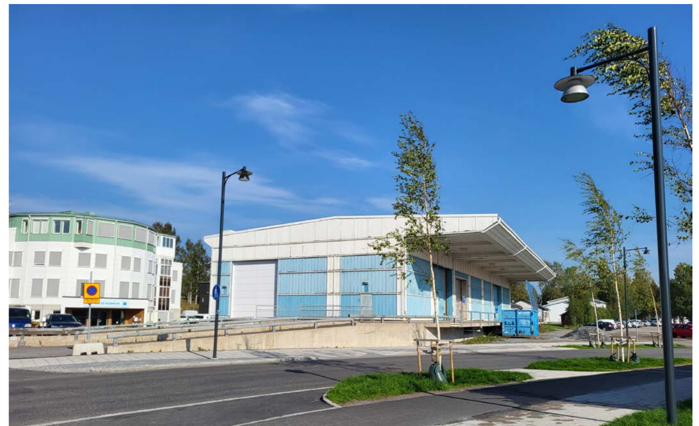
Byggnad med tydlig karaktär kopplat till tidigare verksamhet i hamnen.
