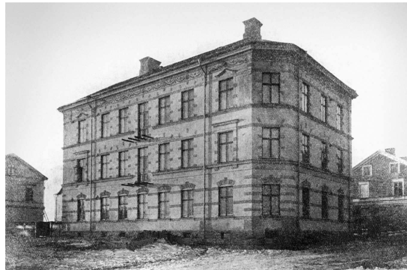
Det s.k. Flemströmska stenhuset i korsningen Prästgatan-Stationsgatan, nuvarande Gösen 3. Fotot är taget år 1899, och byggnaden verkar fortfarande hålla på att färdigställas. Järnbalkarna som sticker ut centralt på huvudfasaden ska komma att bära upp smidesbalkonger. Av bilden framkommer även att det ursprungligen funnits dekor högst upp i fasaden som idag inte finns kvar. Foto: Gustaf Lindell, Luleå kommuns stadsarkiv.
