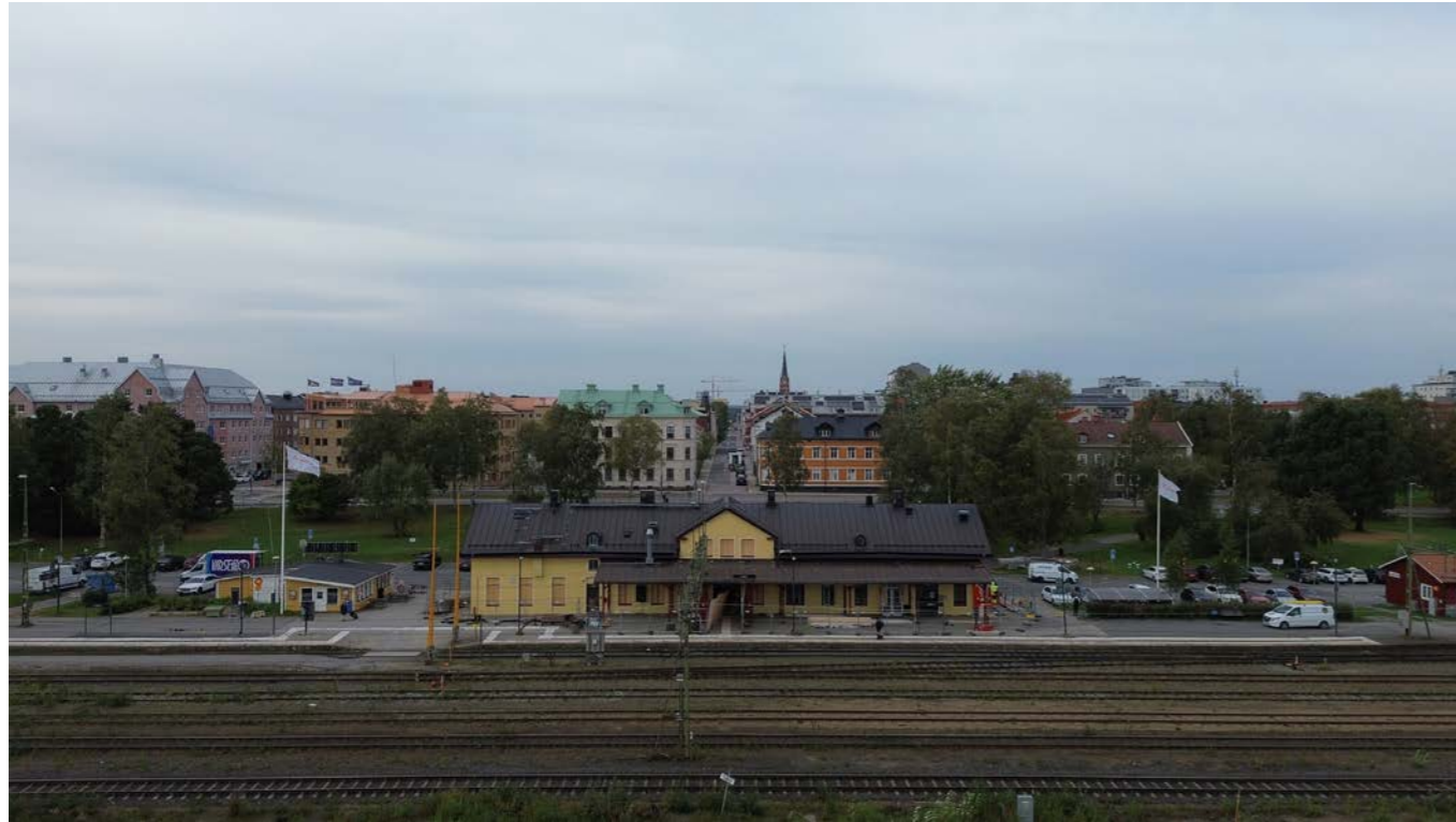
Vy mot stationsbyggnaden från bangårdssidan. I linje med byggnadens mittparti löper Stationsgatan som en rät axel genom hela staden.
