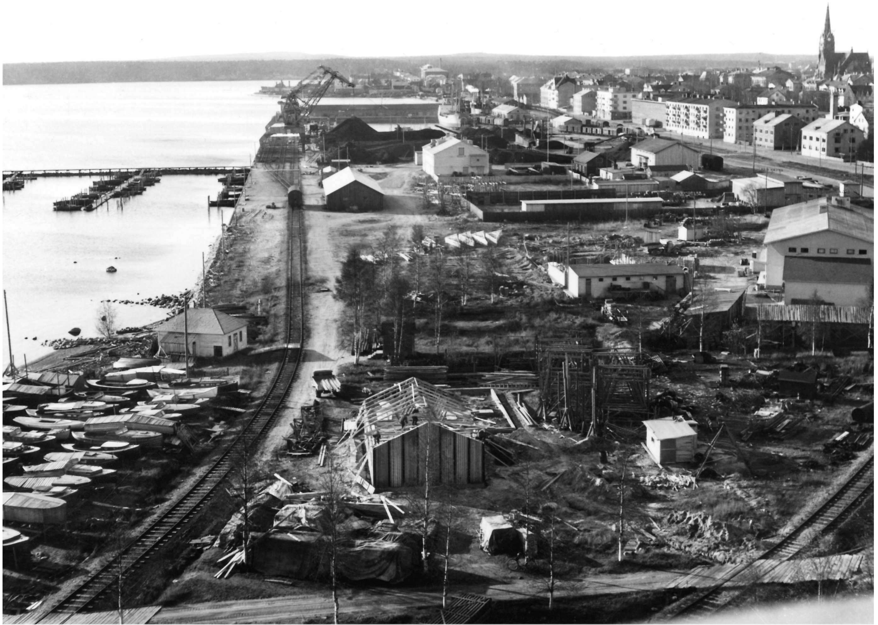
Vy över Södra Hamn år 1950. Båthamn och båtuppläggningsplats till vänster. Mitt i bilden syns kvarteret Stören. Längre fram syns de nybyggda hamnkranarna och ett fartyg vid Långkajen. Uppe till vänster syns bebyggelsen längs Varvgatan. Foto: Luleå kommuns stadsarkiv.
