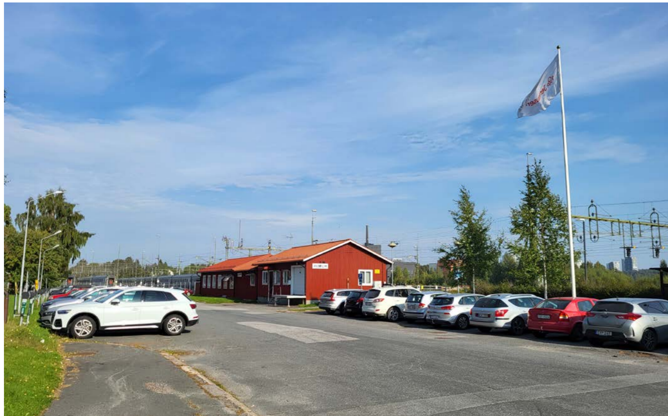
Vy längs väg och parkering som löper närmast stationsbyggnaden i väster, angränsande till järnvägsparken till vänster i bild. Sentida komplementbyggnad i anslutning till stickspår på västra sidan mitt i bild.
