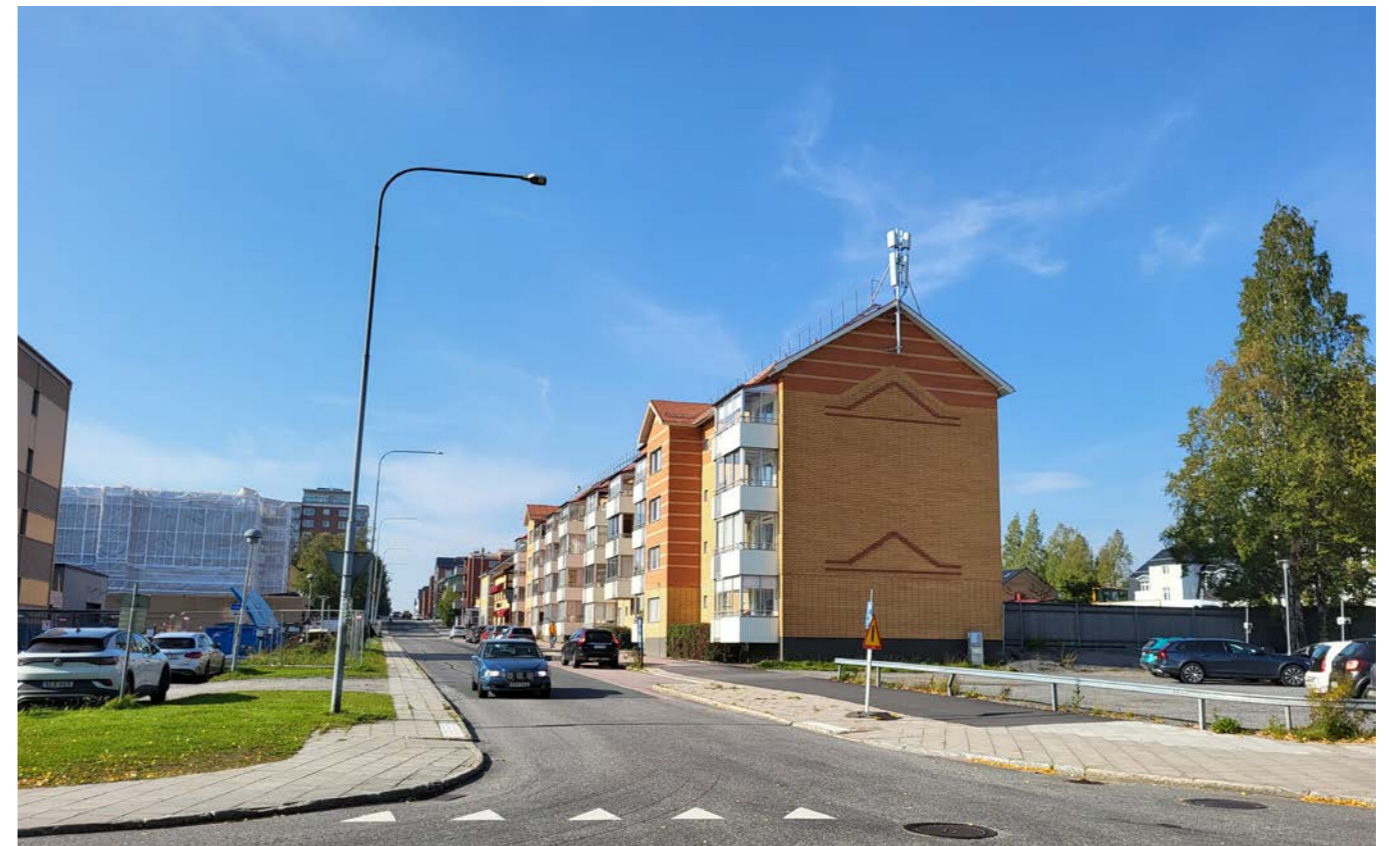
Vy längs Magasinsgatan med Kv Tigern till höger. Avriven tomt närmast till höger. Flerbostadshus i tegel från 1980-talet följer gatan.
