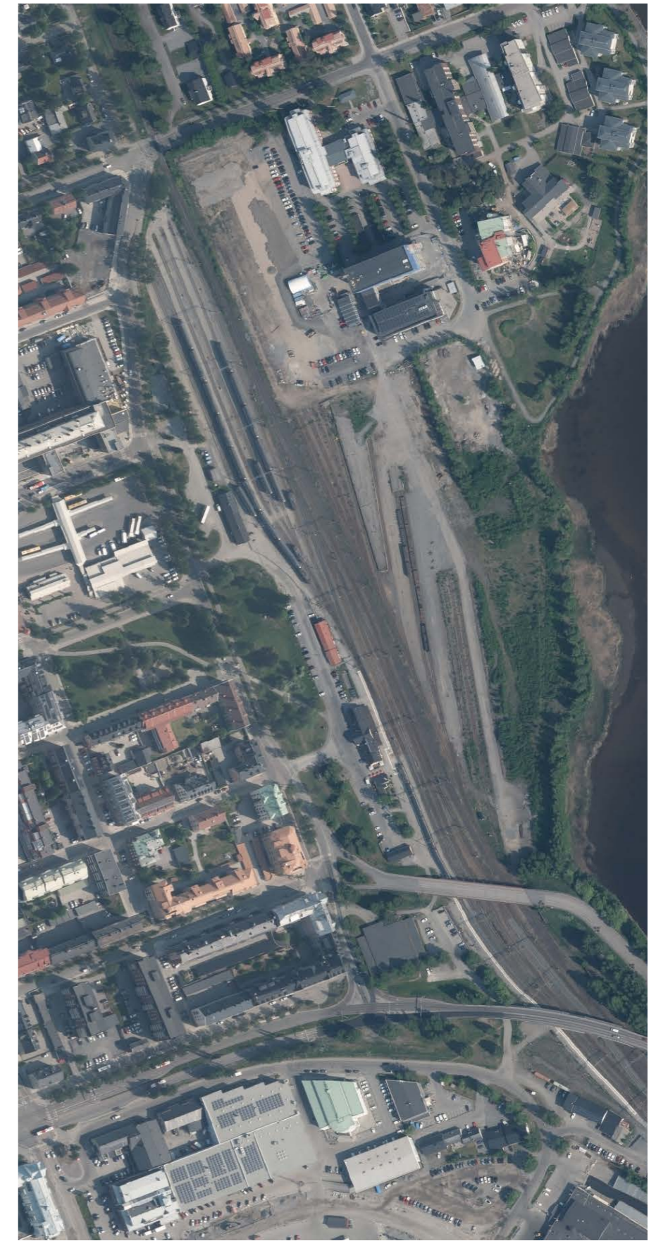
Järnvägsområdet, flygfoto från 2023. Godsterminalen är rivna och strandområdet bortom stickspåren är bevuxet med vegetation. En liten komplementbyggnad har tillkommit, troligen på 1980-talet i nivå med Kv. Loet. Sticksåret som fanns vid det tidigare godsmagasinet nära Prästgatan har tagits bort, och träd har planterats på platsen parallellt med spåren. Källa: Lantmäteriet
