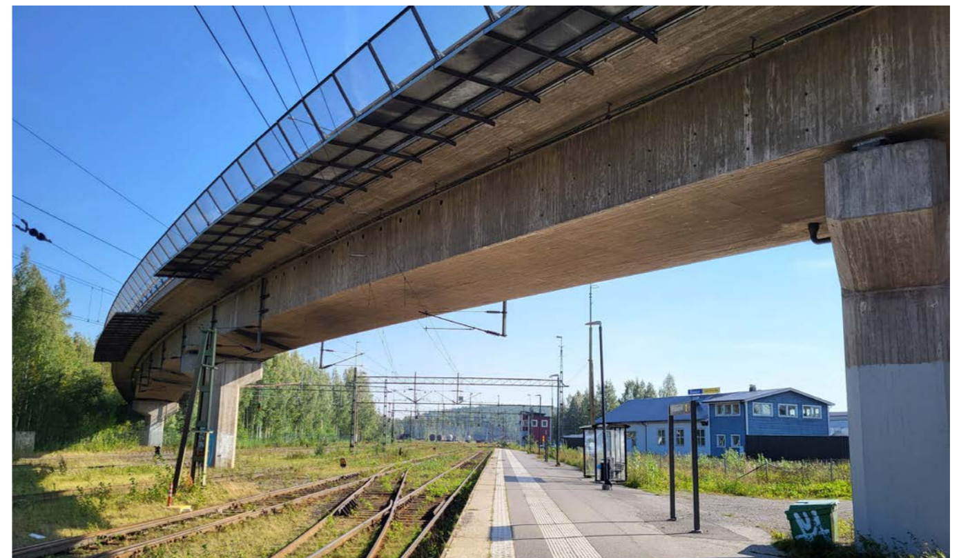
Vy längs spårområdet under Hertsövägen. Komplementbyggnader med historisk anknytning till järnvägen till höger.
