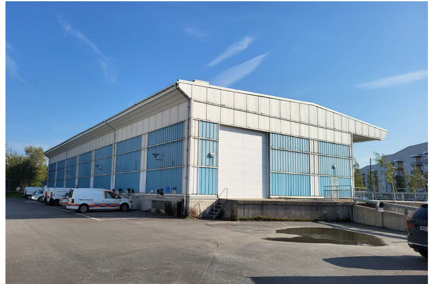
Byggnad med tydlig karaktär kopplat till tidigare verksamhet i hamnen.
