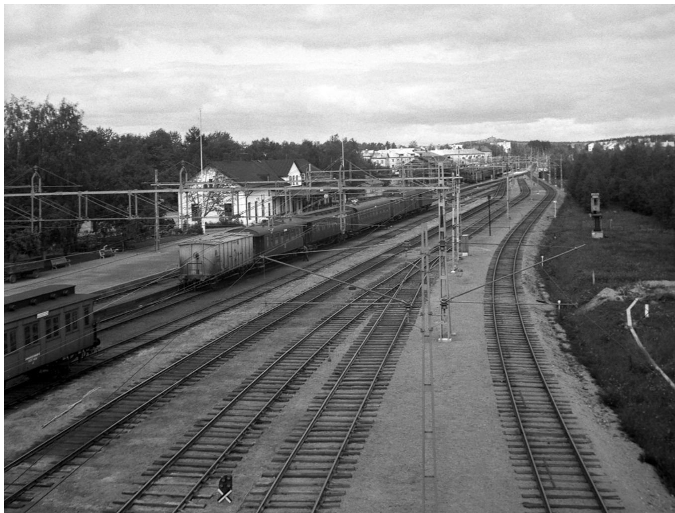
Spårområdet vid Järnvägsstationen år 1949. Spåret längst till höger är det s.k. malmspåret. Fotograferat från Malmuddsviadukten. Foto: Helmer Widlund, Luleå kommuns stadsarkiv.
