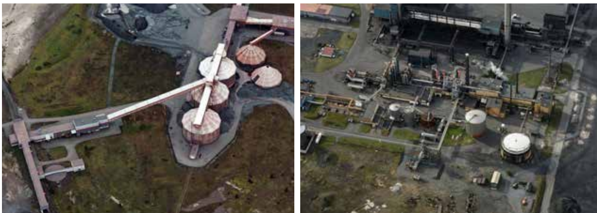
Bild 8: Till vänster bild över SSAB:s verksamhet väster om planområde. Bilden till höger redovisar LKAB:s verksamhet söder om planområde.
