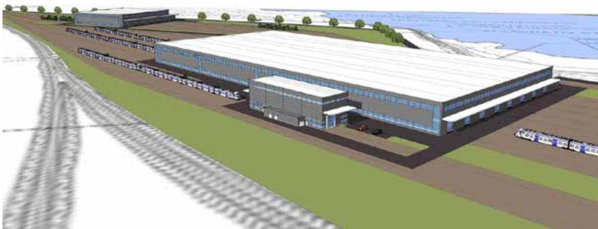
Bild 10: Visualisering av järnvägsanläggningen. Vy mot Hertsöfjärden.
