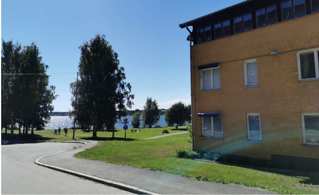
Figur 12: Lågpunkt vid befintlig byggnads sydöstra hörn där översvämningssrisk föreligger.
