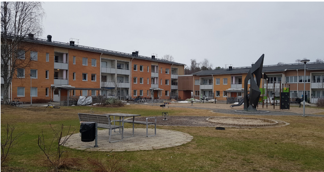
Bild 9: Två flerbostadshus i 2 och 3 våningsplan inom planområdet med tillhörande utemiljö. Alla flerbostadshusen inom planområdet har en likadan tak- och fasadutformning. De två flerbostadshusen är sammanbyggda med en portik mellan byggnaderna.
