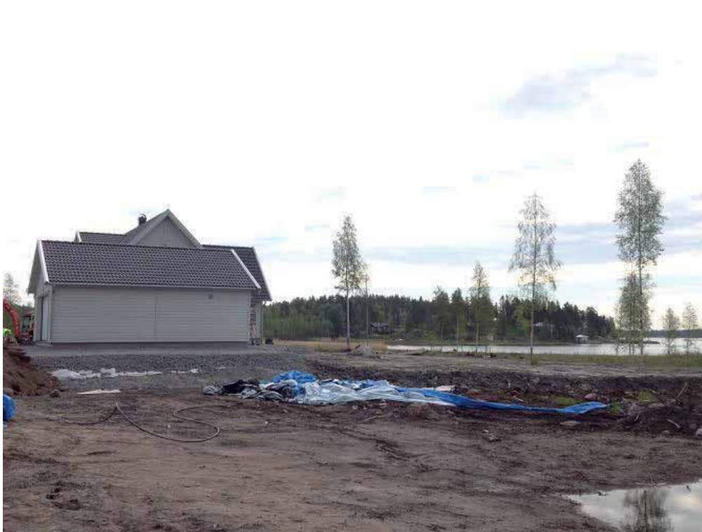
Bild 3: Ett av de befintliga husen. På bilden framgår bland annat mäktigheten på den packade fyllningen. för läge se figur 3.
