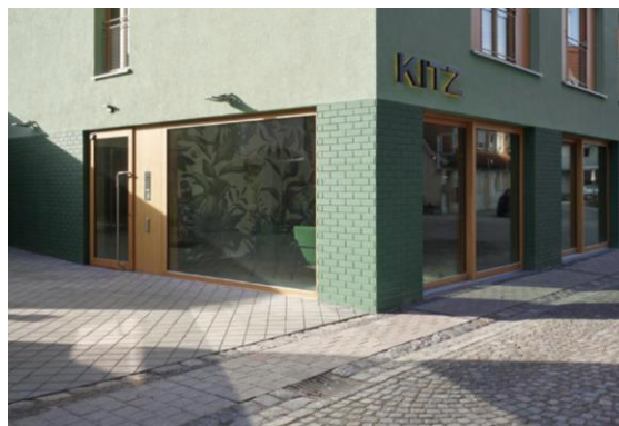
Fasader i kulört puts och sockelvåning i glaserat tegel eller fasadklinker.
