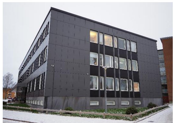
Läkarhuset fick ny fasad under 2010-talet.
