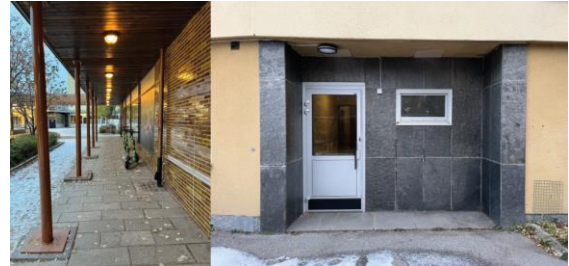
Befintligt skärmtak i Mjöludden centrum samt indragen markerad entré på Snusdosan.
