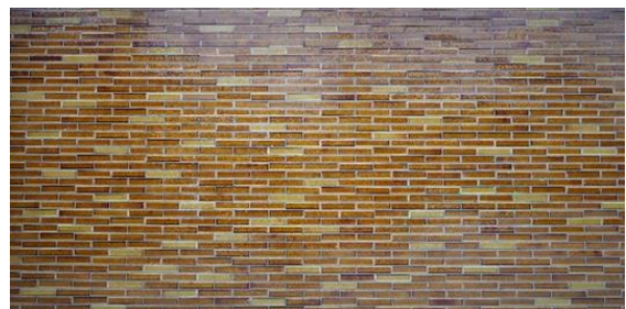
Ursprungligen fanns den gulglaserade fasadklinkern på alla byggnader vilket skapade ett enhetligt uttryck för Mjölkkuddens centrum. Idag finns den kvar på gamla apoteket/konditoriet och på baksidan av centrumbebyggelsen.
