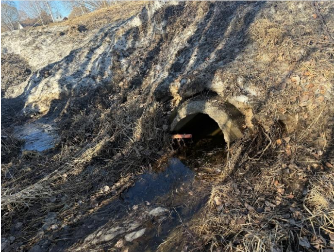
Figur 9. Befintlig trumma under Sunderbyvägen (foto: Smålandsvillan, 2026-04-14).
