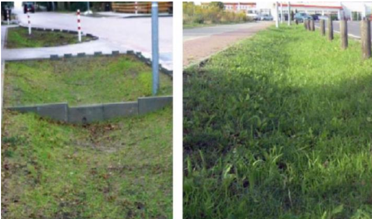
Figur 16. Exempel på hur gräsbeklädda diken kan utformas. Bilderna kommer från Stockholm Vatten och Avfall.
