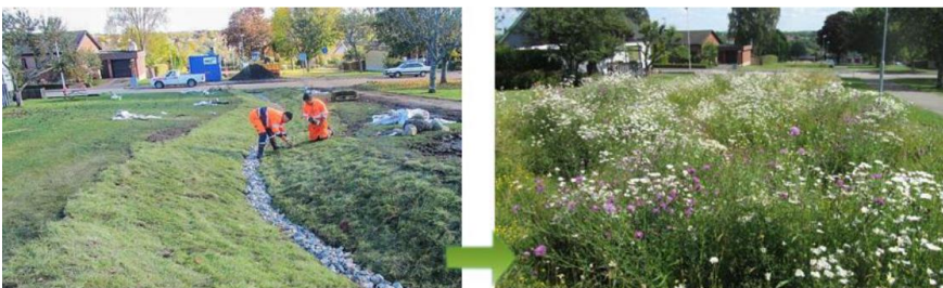
Figur 17. Exempel på hur ett större svackdike kan utformas. Figuren är hämtad från VegTech.
