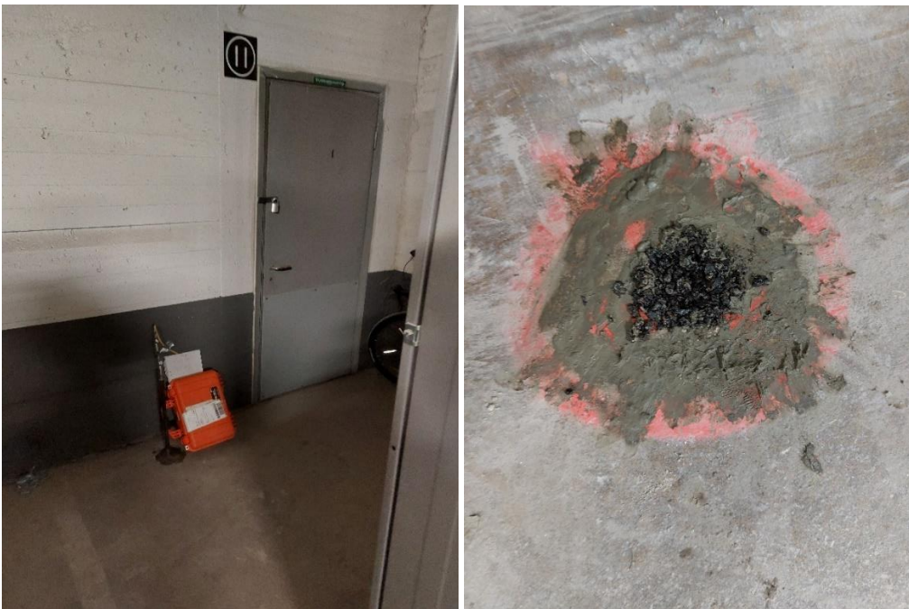
Figur 5. Bild till vänster visar på placering av provpunkt 23W06 som är lokaliserad vid rampen upp från garaget. Bild till höger visar på återställt borrhål som tätats med bentonitlera och ett lager med kallasfalt.
