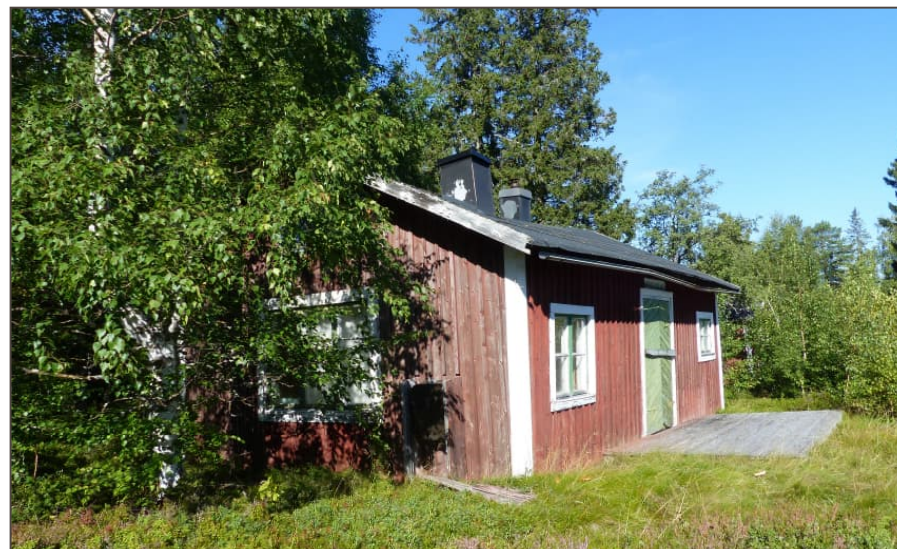
Bild 22. En av de äldre stugorna på västra sidan inom Bf-området. Denna stuga är lite större än andra och står i skogsbrynet.
