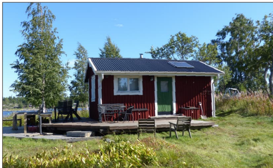
Bild 38. En byggnad inom det östra BF-området som inte finns med på flygfoto från 1975 men som har fiskelägeskaraktäri förutom det stora trädäcket.
