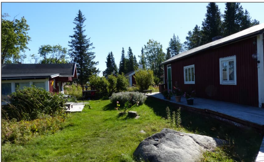
Bild 40. En av de äldre stugorna inom det östra BF-området med flera komplementbyggnader som bildar ett gårdsrum.
