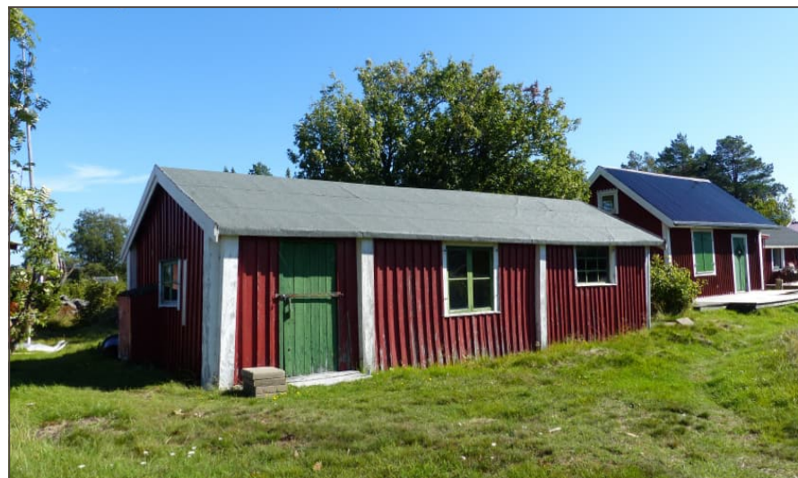
Bild 32. Huvudbyggnad inom Bf-området på östra sidan viken som är målad med akryaltfärg och i behov av åtgärder. Den verkar också vara äldre än detaljplanen.
