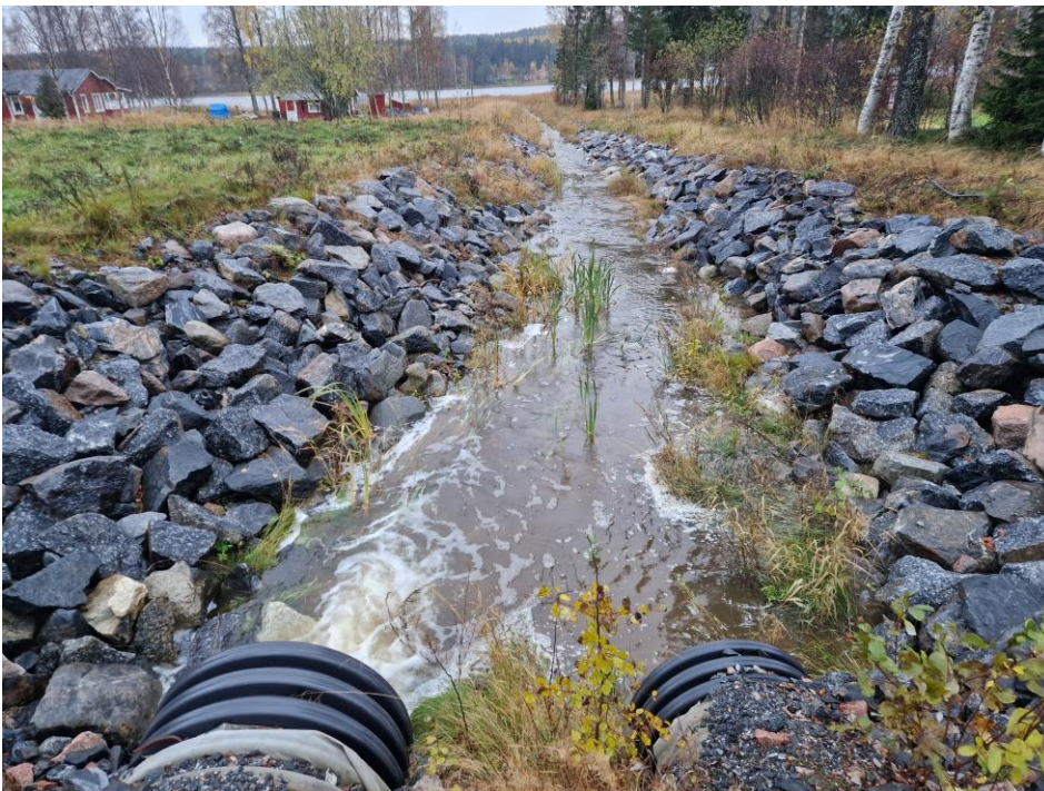
Figur 3. Erosionsskyddat dike som är utsläppspunkt för det befintliga bostadsområdet Dalbo. Dagvatten leds till diket huvudsakligen via ledningsnät.
