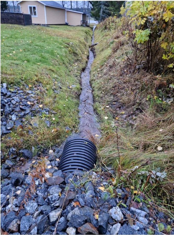
Figur 10. Befintlig enskild trumma (300 mm) under Revelsudden-vägen som avvattnar ett skogsdike inom planområdet. Platsbesök 2024-10-11.
