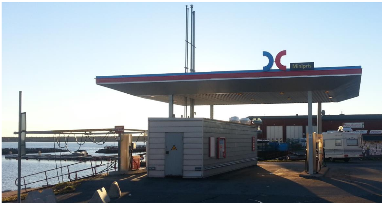
Figur 3. Foto från östra sidan av OKQ8. [8]
