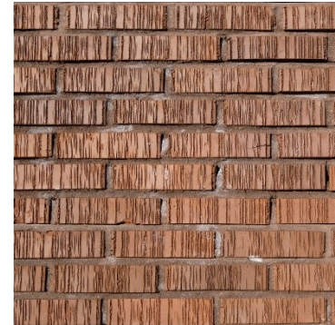
Fig 52. Mörkt lertegel med riven yta.
