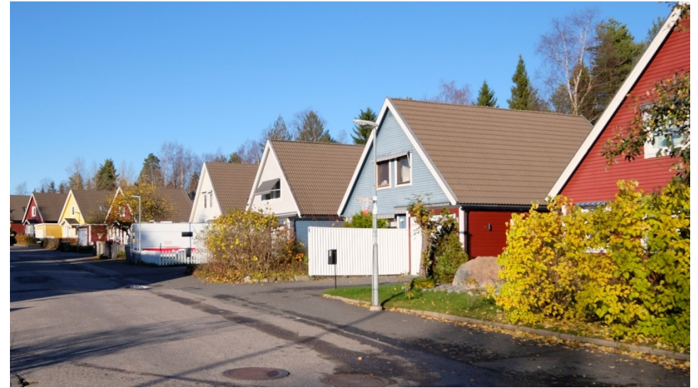
Fig 27. Bebyggelsen på Berget utgörs av villabebyggelse i olika former och är anpassad till topografin. På bilden syns hus i 1 1/2 plan med gavelsidan och garage mot gatan.
