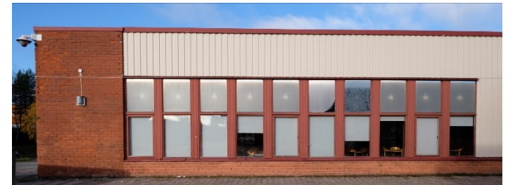
Fig 47. Skolbyggnaden i centrum karaktäriseras av långsträckta fönsterband, tegelpartier och träpanel.
