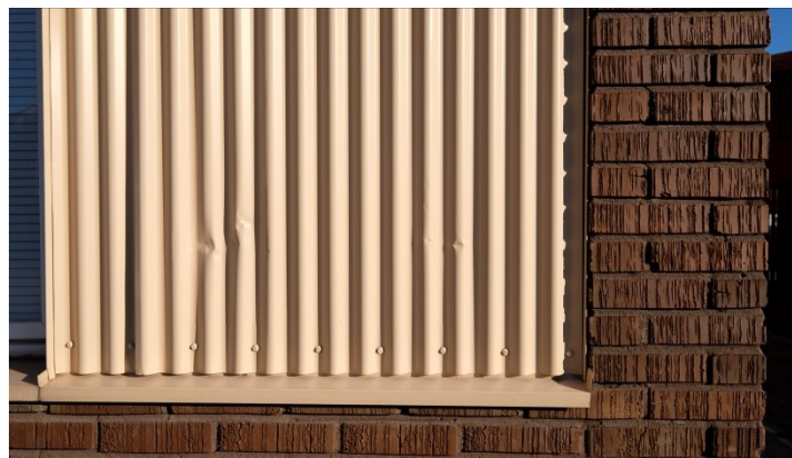
Fig 51. Sinuskorrigerad plåt som markerar våningarna.
