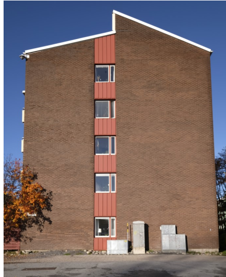
Fig 50. Höghusens gavelsidor, solida tegelfasader av mörkt lertegel, pulpettak med höjdförskjutna huskroppar och markerat vertikalt fönsterparti..
