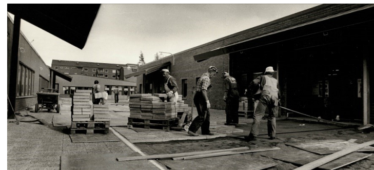
Fig 8. Läggnig av betongplattor i Porsö centrum. År: okänt. Arkiv: NBM
