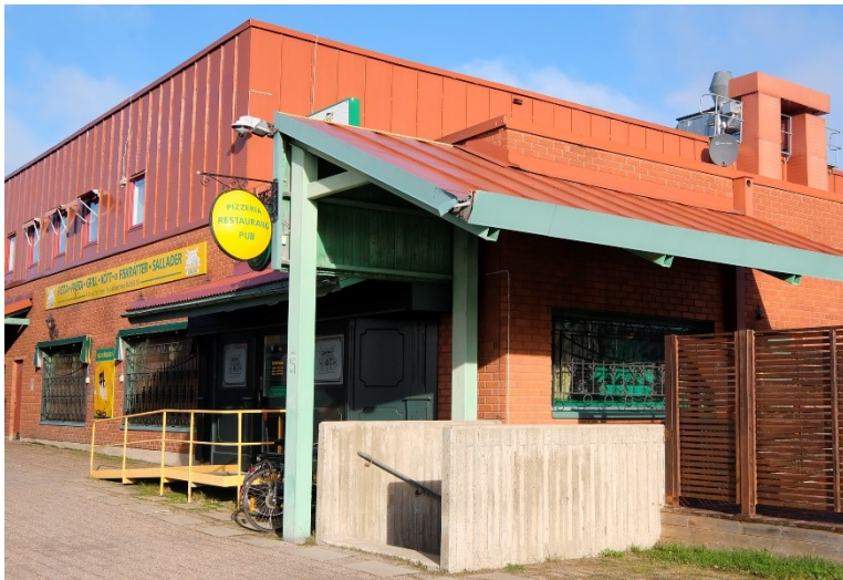
Fig 41. Skärmtak med synlig konstruktion målade i olika grundfärger för att tydliggöra byggnadernas funktioner.
