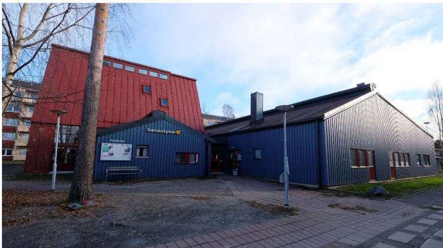
Fig 16. Kyrkobyggnaderna har försetts med grövre panel sen uppförandet och taket är tilläggsisolerat. De tydliga linjerna är något utsuddade. Kyrksalen är sig lik.
