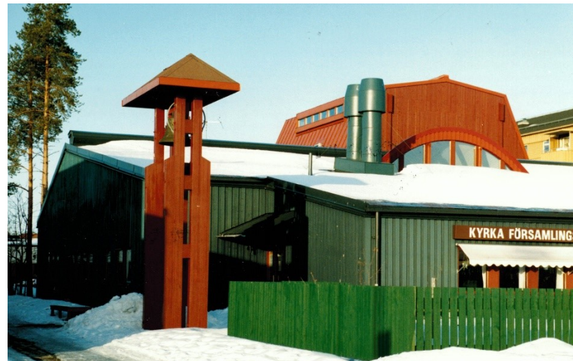
Fig 17. Porsö kyrka i sin klara färgsättning och utmärkande byggnadsvolymer. År: 1993 Arkiv: NBM
