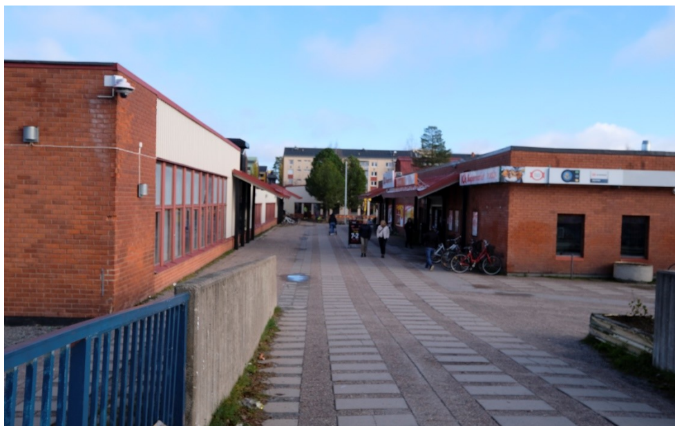
Fig 20. Idag är centrum i stort behov av underhåll sett till flagnad färg på räcken, träsiga betongelement och tjälskadad markbeläggning. I övrigt är byggnadsstrukturen sig lik.
