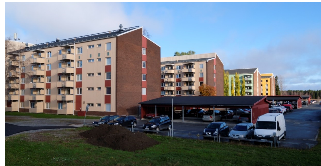
Fig 22. Byggnaderna på Lill-Porsön har idag en förvanskad fasad. Fasaden har tilläggsisolerats och fönstren går inte längre ut i fasadlivet. De vertikala och horisontella raderna är uppbrutna med färg och dekor. Färgsättningen separerar byggnadsraderna.
