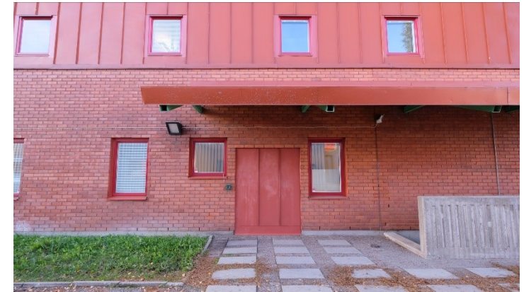
Fig 45. Solida tegelväggar av rött tegel som går igen i den falsade plåtfasaden. Fönstersättningen följer insidans funktion och upplevs lekfull från utsidan.
