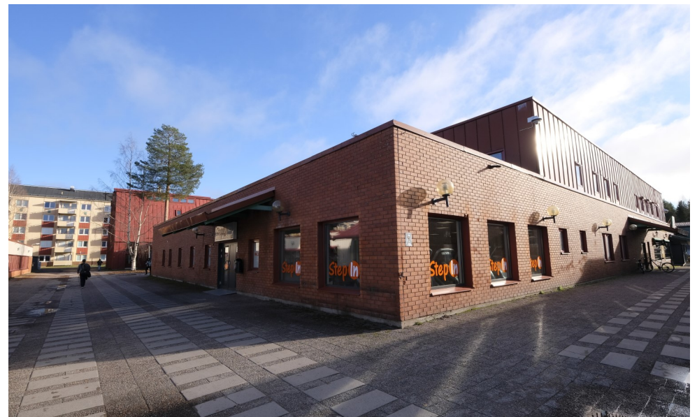
Fig 37. Vårdbyggnaden med ytterligare en våningshöjd vars volym markerats med ett annat material, badtäckt, falsad, röd plåt.
