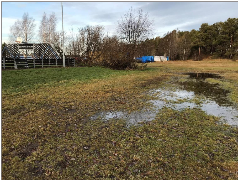
Figur 8. Bild på lågpunkt från utredningsområdet där dagvatten från tidigare regn blir stående och först efter tid infiltrerar i mark. Foto: Lovisa Renberg.
