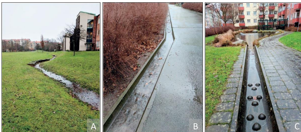
Figur 19. (A) Svackdike med erosionsskydd, (B) och (C) kanal i gata som transporterar dagvatten. Alla bilder är från Augustenborg. Foto: Kristoffer Eliasson (Eliasson, 2018).
