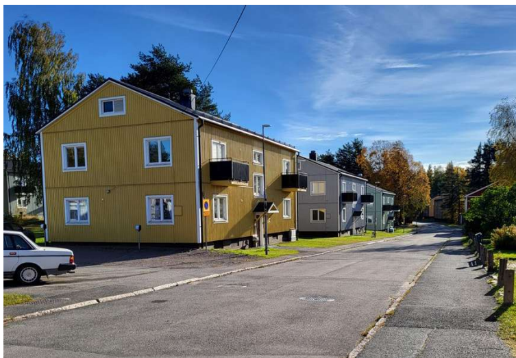
Vy mot söder längs Sandgatan, Kv. Magneten till vänster.
