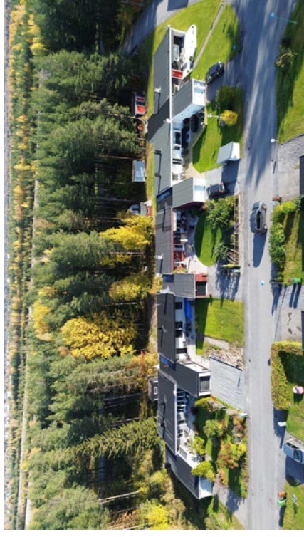
Flygvy mot längan med kedjehus i nordöst.
