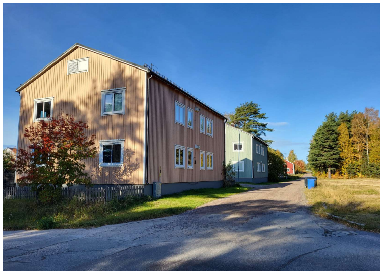
Vy längs Bärstskärsgatan mot nordväst med Kv. Magneten till vänster. De avrivna tomterna i Kv Järnet till höger, bevuxna med gräs och träd.
