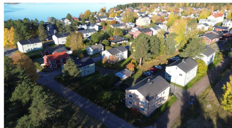
Flygvy över flerbostadshusen inom Järnet som angränsar till rutnätsplanen. Den grusade gatusträckningen Börstskärsgatan till höger, Båthamngatan till vänster.
