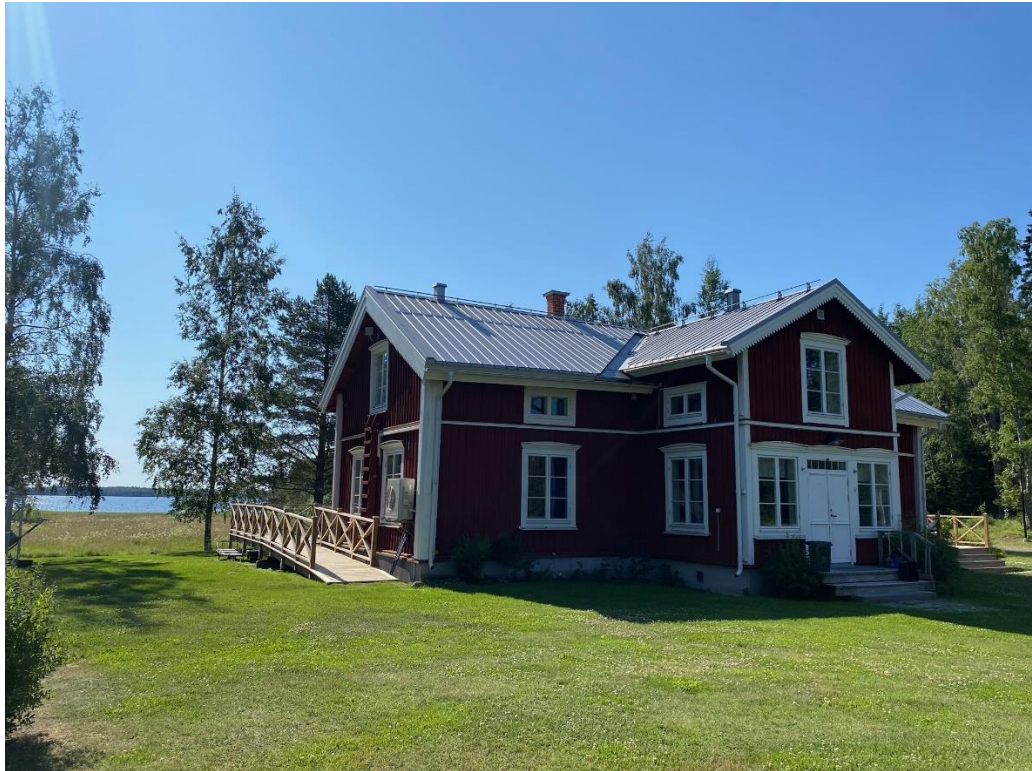
Området sett från norr
