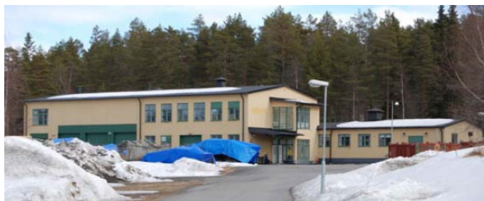
Figur 6. Foto byggnaden C7 inom blivande kvarteret Terränglöparen. Källa: Piteå Museum 2009
