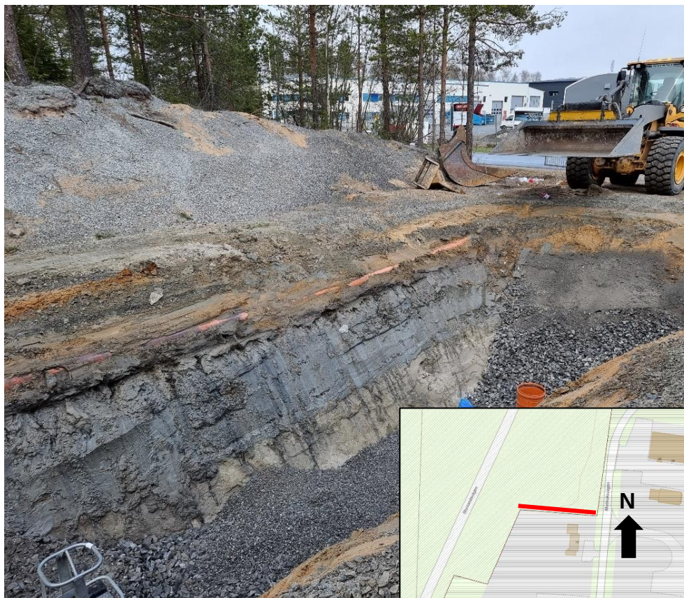
Figur 6. Foto taget i nordöstlig riktning på utfört schaktarbete. Den röda linjen i rutan nere till höger avser urgrävt område (NYAB, 2022-06-16).
