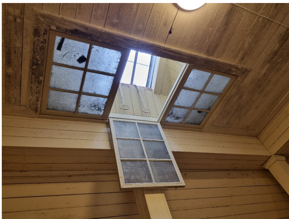
Vindsfönstren i vindsvåningen är konstruerade med glastrutor i inre och yttre nivå. Foto 2025.
