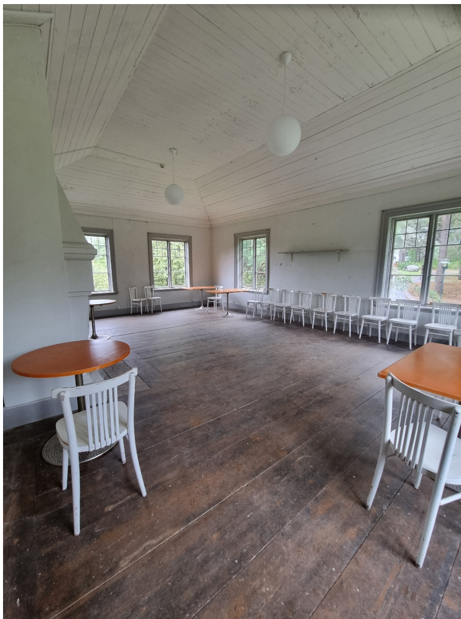
Den stora sessionssalen på övre plan har förhöjd takhöjd och täcks av ett innertak format som ett spegelvalv i trä. Foto 2025.
