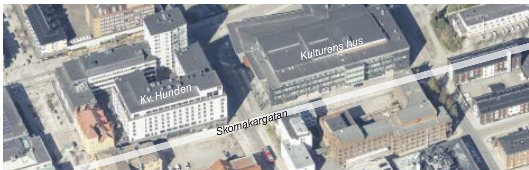
Bild 14. Vy sett från öst. Både Kulturens hus och kvarteret Hundens fasad mot Skomakargatan är mörkt grå med på- och urlastning för varutransporter. Bildkälla: Blom
