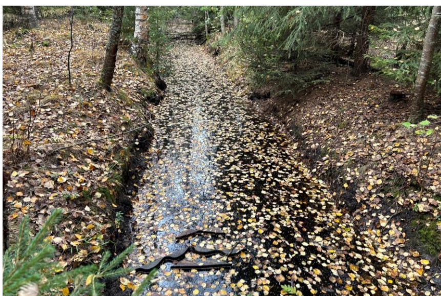
Figur 3. Brett skogskantat dike som korsar kartläggningsområdet i väst, från väg 97 i norr och mot Ektjärnsvägen i syd.
